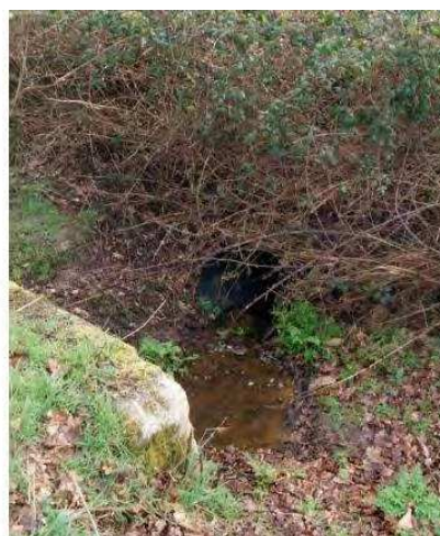
Figure 204 : Photographie sur site : PDV n°8 - connexion par buse avec l'étang nord de l'autre côté de la route (Photo prise depuis la route départementale D107) en partie Nord
